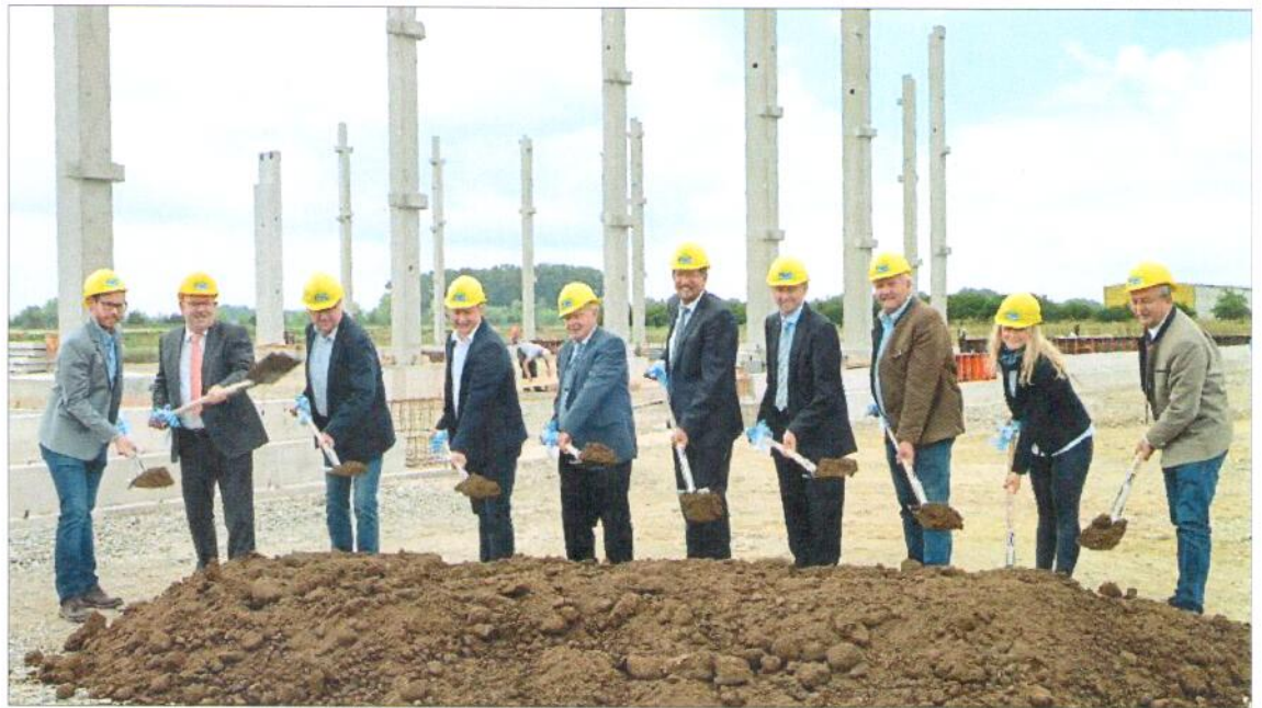
Firmeninhaber Gunter Hemmel (5.v.l.) setzte mit Ehrengästen wie Landrat Josef Laumer (rechts) den Spatenstich für den Büro- und Hallenneubau der Luftfahrttechnik Avionik GmbH am Flugplatz Straubing-Wallmühle.
